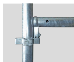
水平材の組立
